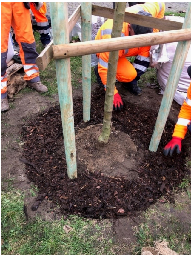
Fot.14. Powstały rów wokół bryły korzeniowej należy uzupełnić przekompostowaną korą lub zrębkami.
